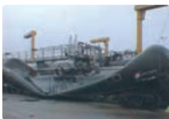
شکل ۴-۴۱ سرد شدن هوای درون مخزن باعث کاهش فشار این هوا و در نتیجه محاله شدن مخزن شده است.
